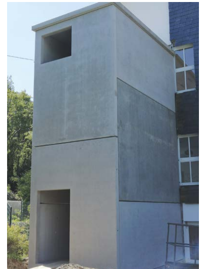
Umbauarbeiten am Gemeindehaus
